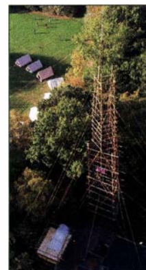
Der Antennenturm wurde lediglich aus Holz und Seilen erbaut, was in nur drei Tagen gelang.
