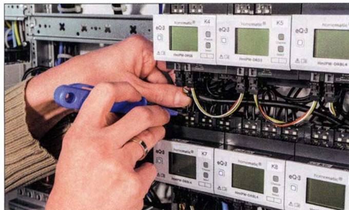
Bild 17: Die neueste Generation Homematic IP Wired, interessant für Bauherren, Renovierer und das Fachhandwerk, arbeitet busbasiert. Fotos, Screenshots: ELV/eQ-3/Schulz/Penzler
