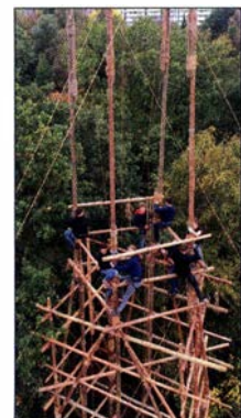
Der Antennenturm wurde lediglich aus Holz und Seilen erbaut, was in nur drei Tagen gelang.
