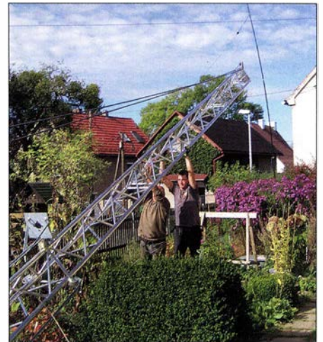
Bild 9: Das Schubteam bei der Arbeit zum Aufrichten des Mastes
