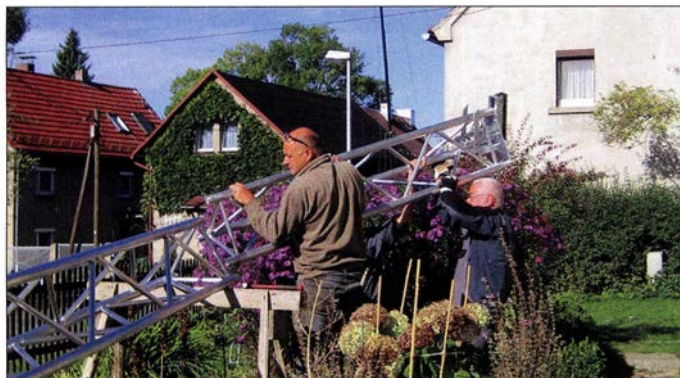
Bild 7: Kleines Richtfest mit den hilfsbereiten Nachbarn
