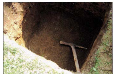
Bild 3: Das Ausheben der Fundamentgrube war im unteren Teil schweißtreibend.
