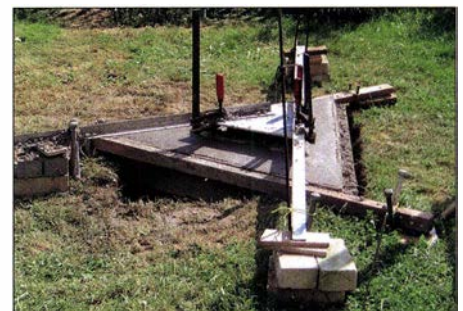
Bild 4: Fundamentguss mit sorgfältig fixierter Unterkonstruktion
