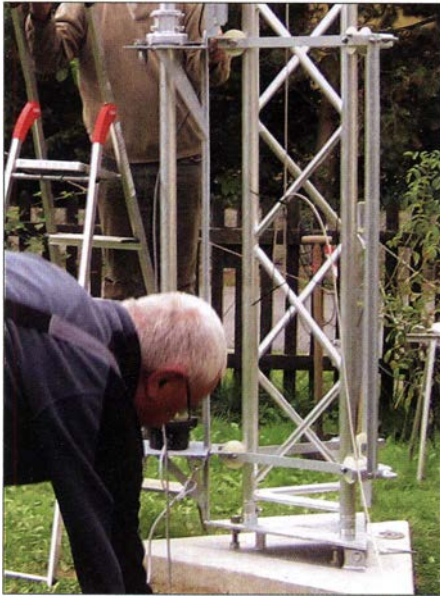
Bild 10: Details der Unterkonstruktion; an der Spitze der Dreiecksplatte sieht man – nach dem Aufrichten – die Verschraubung mittels M12-Schraube in der Unterplatte. Rechts sieht man den Gewindestab, der das Kippen des Mastes erlaubt.
